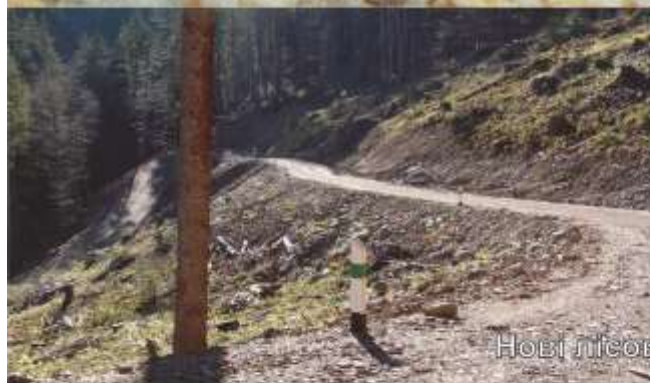
Укріплення земляного полотна кам'яним накидом
