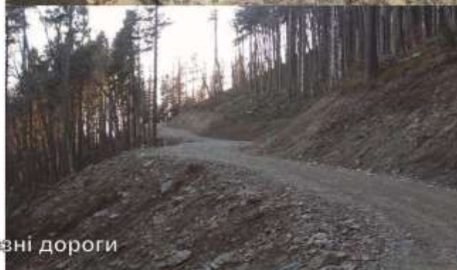
Укріплення земляного полотна кам'яним накидом
