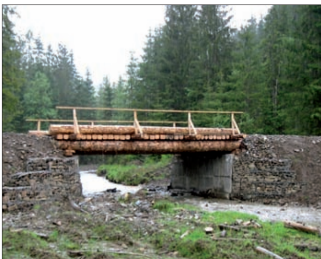
Рис. 4. Загальний вигляд комбінованого моста
