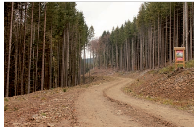
Рис. 2. Загальний вигляд лісової автодороги, прокладеної гірським схилом
