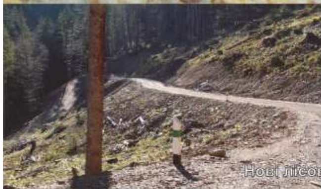
Укріплення земляного полотна кам'яним накидом
