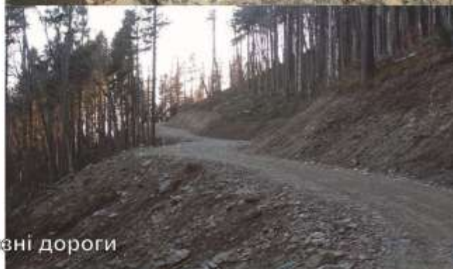
Укріплення земляного полотна кам'яним накидом
